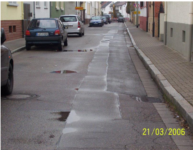
Zustand der Moltkestraße im Februar 2007
